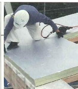
キューワンボードMAの施工例
