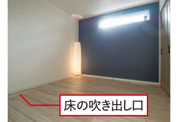
2階のLDK(左)はキッチン上部の壁と床に吹き出し口を設けた。1階の寝室は小さいので吹き出し口は床のみ
