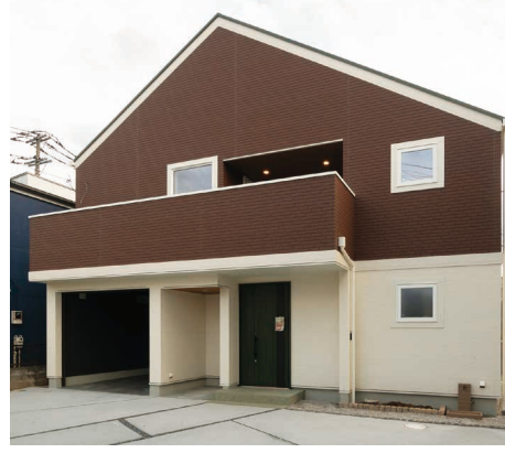
エクセレントハウジングシステム導入1棟目のK邸
